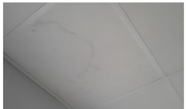
- spor etter lekkasjar i takplater
